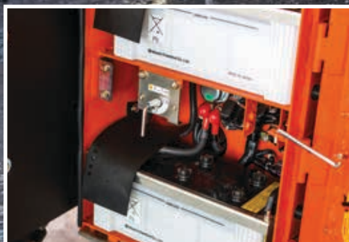
La manutenzione della batteria risulta facilitata.
