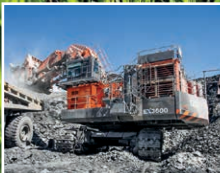
Escavatori giganti EX
